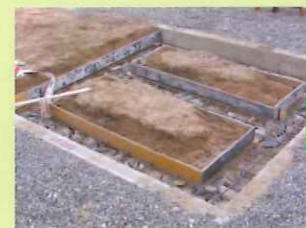
●鉄筋コンクリート基礎
